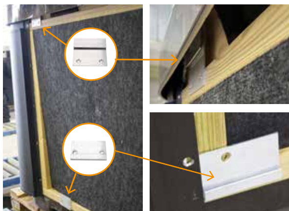
1. Naci nij panel w gór i włó rowki na dolnej kraw dzi panelu w zaczepy znajduj ce si na dolnej kraw dzi ramy wanny.
